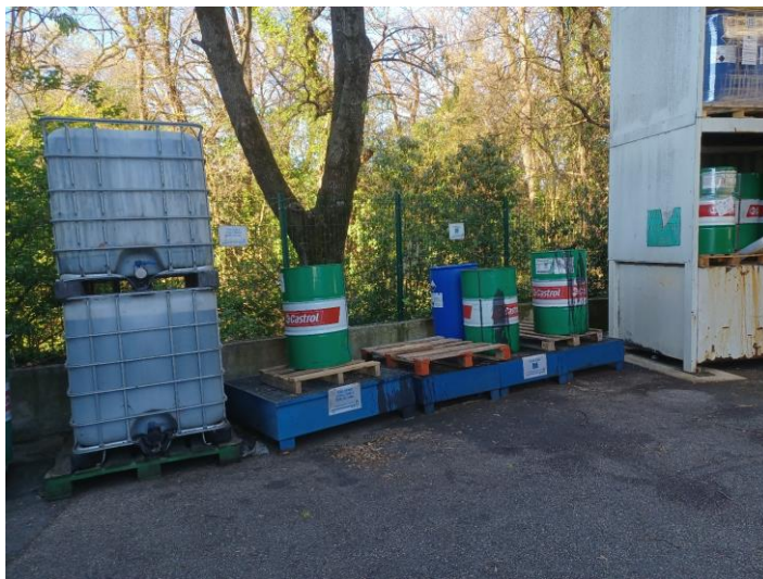
Zone à déchets (STEP)
