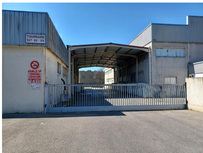
Bâtiments B8 et B9
