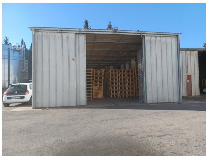
Bâtiment stockage BATEX
